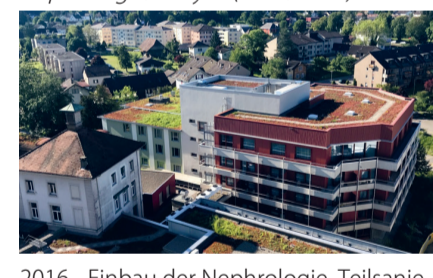
2016- Einbau der Nephrologie, Teilsanierung der Onkologie, neue Frauenklinik im Haus Süd, Neubau Verwaltungsgebäude Finanz- und Rechnungswesen, Gestaltung des Haupteingangs
