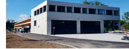
Neues Parkhaus mit Ambulanz Garage und Rettungsdienst Büro.
