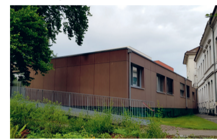
Oben: Der Pavillon neben dem Ärztehaus 1 diente als Provisorium für eine Bettenstation (2015-2020). Unten: Das Haus Süd mit neu vier Stockwerken beinhaltet die Intensivstation, die Frauenklinik, die Onkologie und die Nephrologie/Dialyse (2016/2017).
