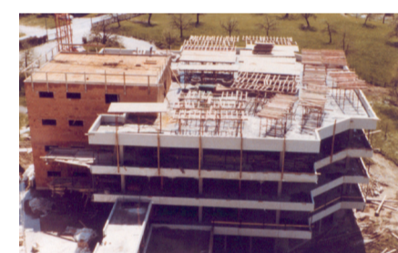
Neubau Geriatrie mit Eröffnung im Jahr 1979. Heute ist in diesem Gebäude die Frauenklinik und die Intensivstation.
