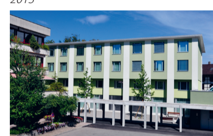
2015- Provisorium Bettenpavillon für 2020: Umbau Haus Süd und Aufstockung neue Intensivstation
