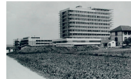
Bau des Bettenhochhauses und des Behandlungstraktes zwischen 1966-1971.
